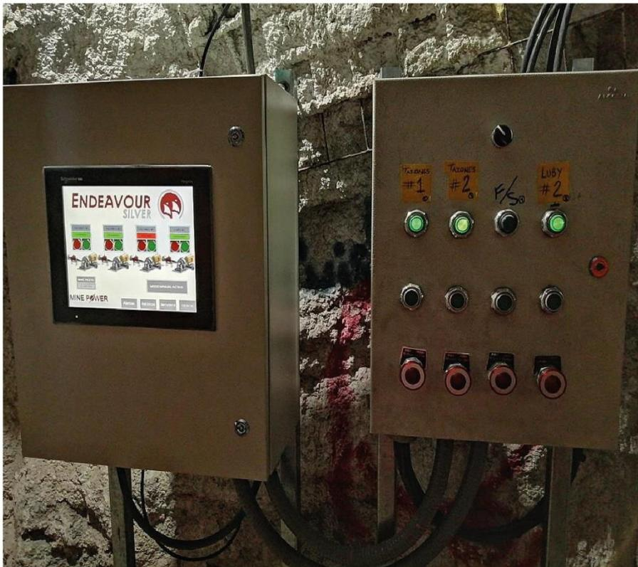
Puesta en marcha de área de trituración integrando PLC y HMI con comunicación profibus al CCM
